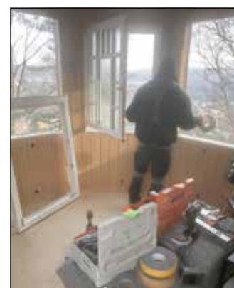
Ein Balken müssen wir leider gleich mit reparieren. 😊
